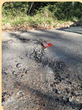
Image de couverture : Rupture de surface remarquable pour un séisme de magnitude 5, en France. L'ampleur du décalage est faible, de l'ordre de 2 cm. Coordonnées de l'observation sur la photo : 44.5307N - 4.6689E - élévation : 170 m. Photo : Jean-François Ritz
