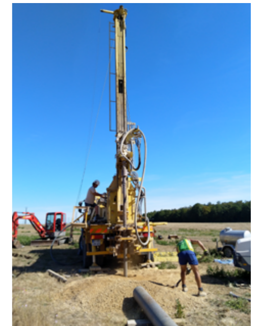
1 Foration du site de Gouttières (27), le 5 août 2020, par le BRGM (L. Ardito et M. Parrella) pour la future station GOTF de Résif-RLBP - crédits D. Fligiel/P. Gernigon, Osuna.
