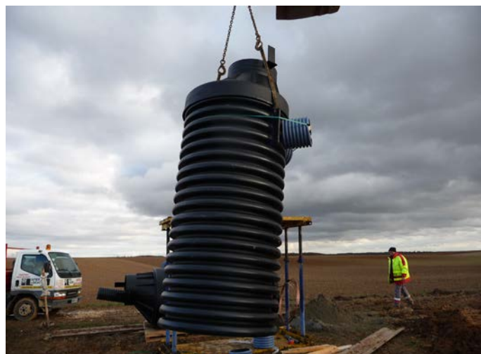
Figure 3 : installation de l'un des prototypes de puits sismique sur le site de Clévilliers (Eure et Loir) en novembre 2012. Source : RESIF.
